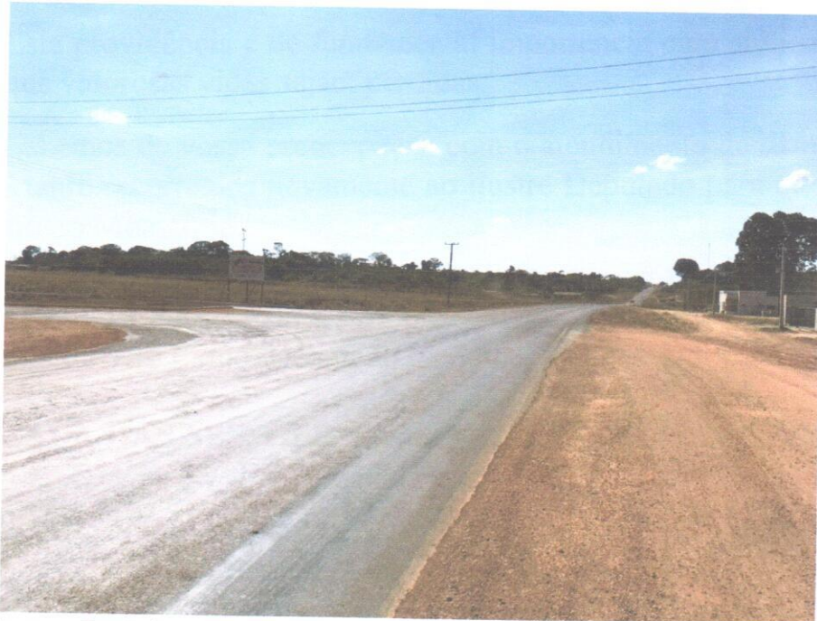
Figura 6 – Vista MT – 423 sentido cidade de Sinop / MT.
