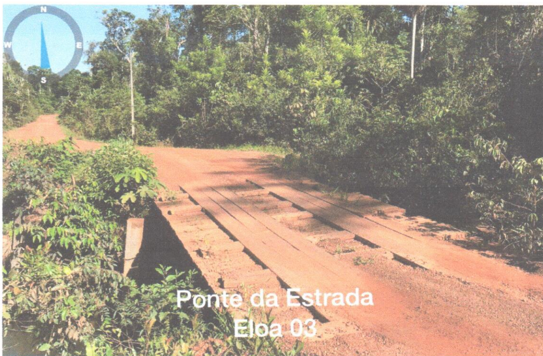
Figura 10 - Ponte da Estrada Eloá.
