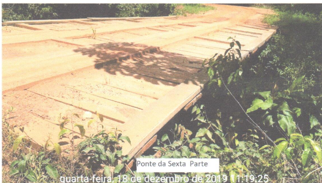
Figura 1 - Ponte localizada na Sexta Parte.
