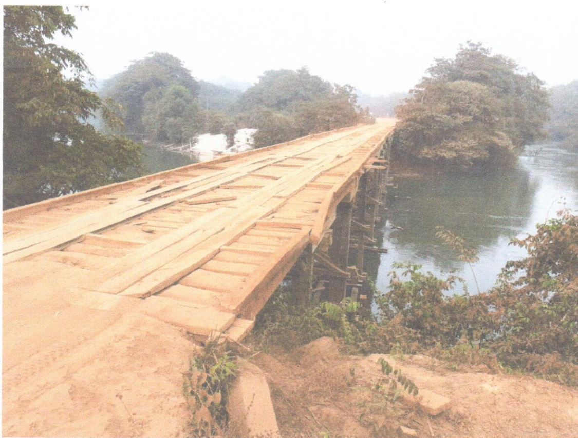
Figura 14 - Ponte Sobre o Rio Azul na Rodovia MT-429, .
