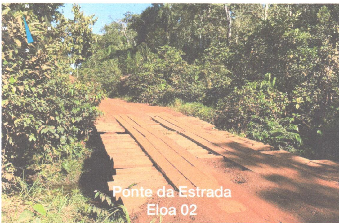
Figura 9 - Ponte da Estrada Eloá.
