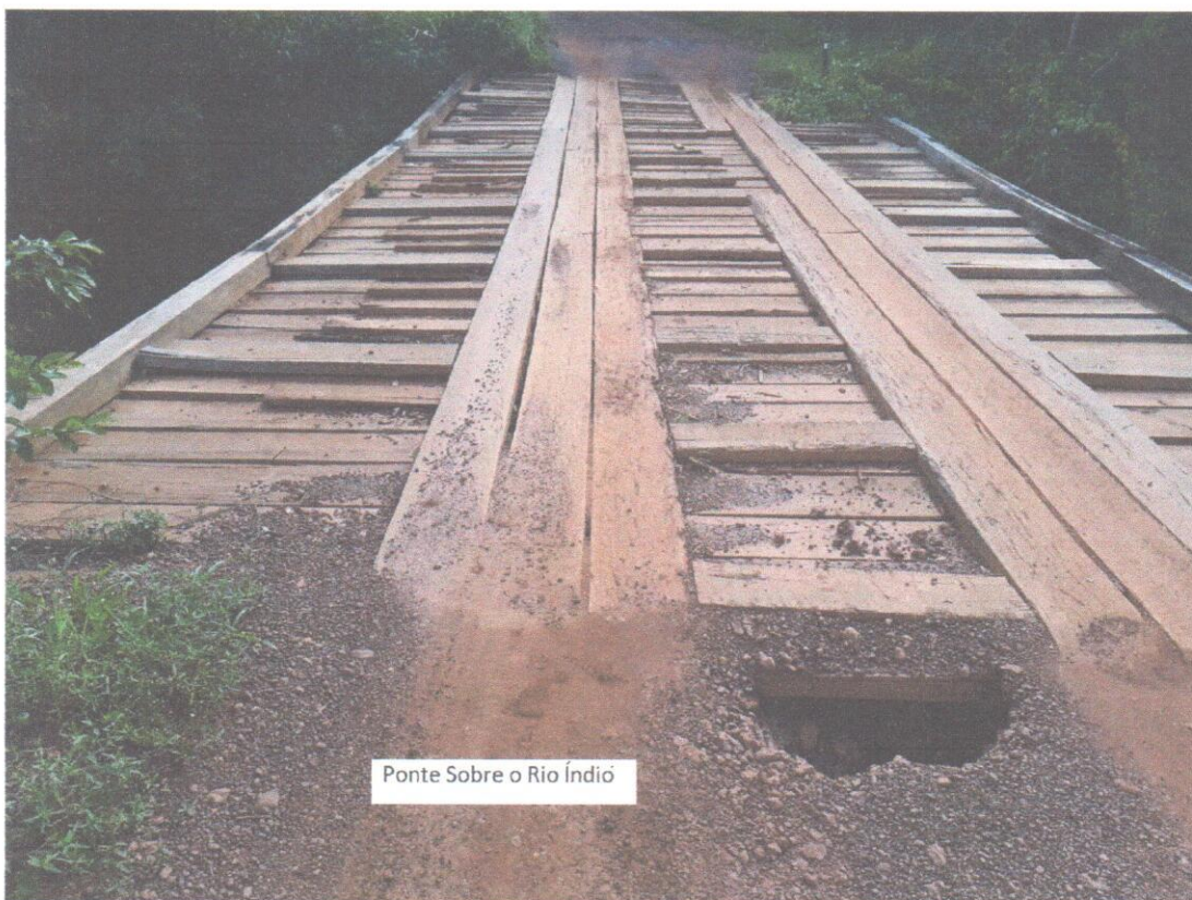
Figura 5 - Ponte sobre Rio Índio.
