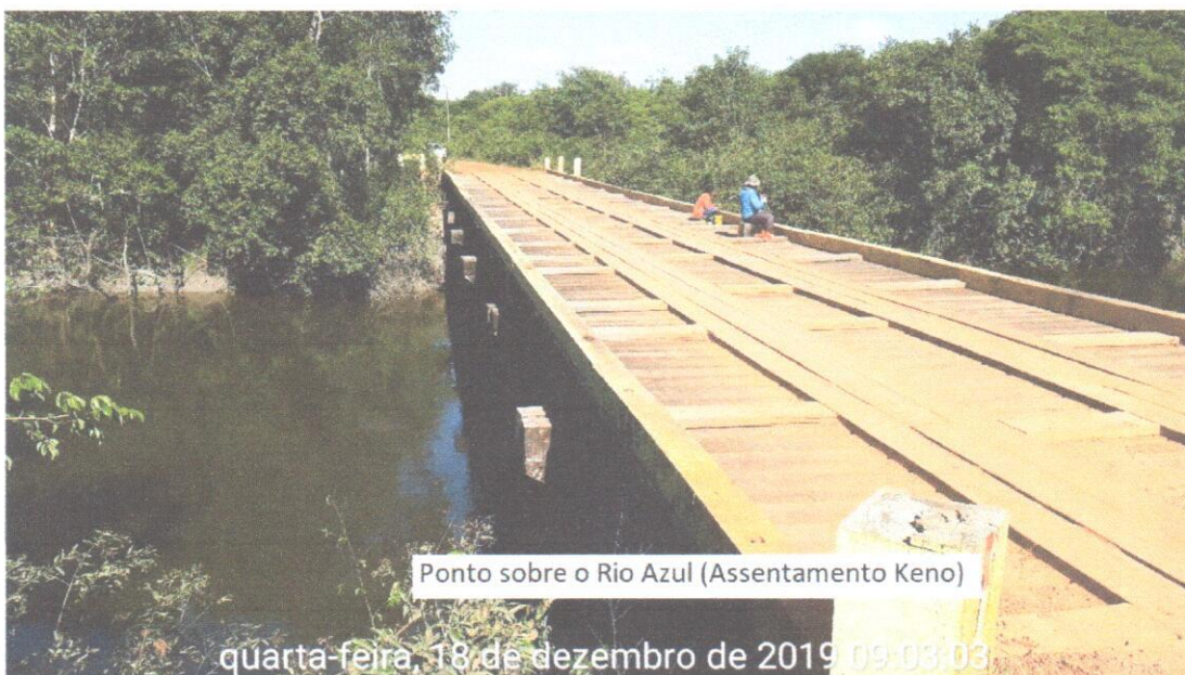
Figura 3 - Ponte sobre o Rio Azul.
