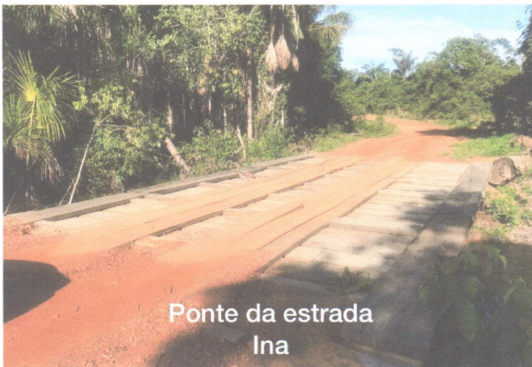
Figura 7 - Ponte da Estrada Iná.
