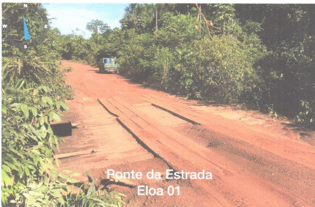
Figura 8 - Ponte da Estrada Eloá.
