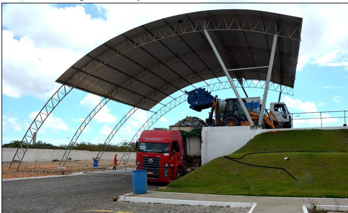
Figura 32 – Estação de transbordo Nova Parnamirim
